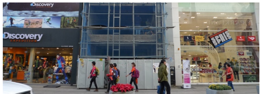
b. 건축물 공사 중
